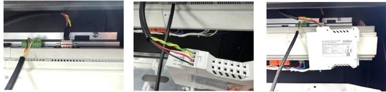
10. Das Patchkabel vom ESS Gateway zum Router zusammen mit den Leistungskabeln durch das freie Loch der 3-Lochtülle verlegen und mit der mitgelieferten PG Verschraubung fixieren.
